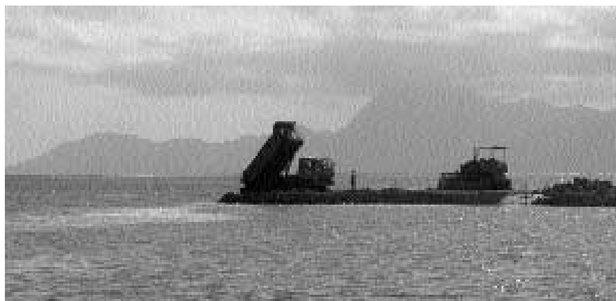
Le remblaiement de la zone nord a commencé le 14 août dernier
