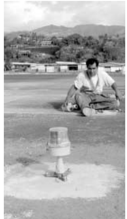
Un des 300 feux constituant le nouveau balisage lumineux.
