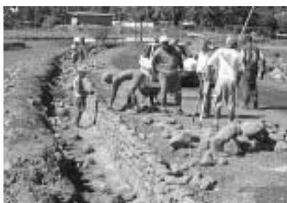
Des fossés d'assainissement sont nécessaires à l'écoulement des eaux.
