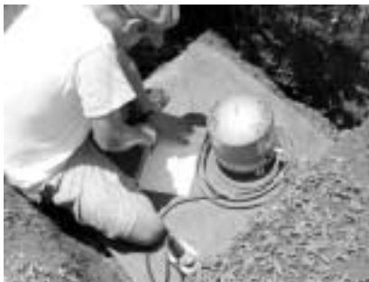
L'installation de chaque capteur est rigoureuse. Rien ne doit fausser les relevés.
