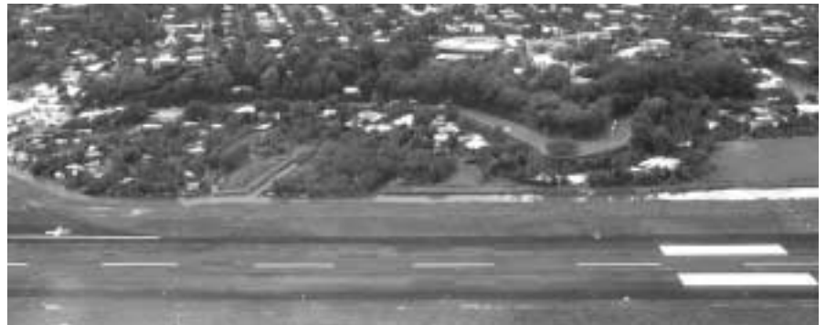
La chaussée doit être « redressée » sur un tronçon de 90 mètres.
